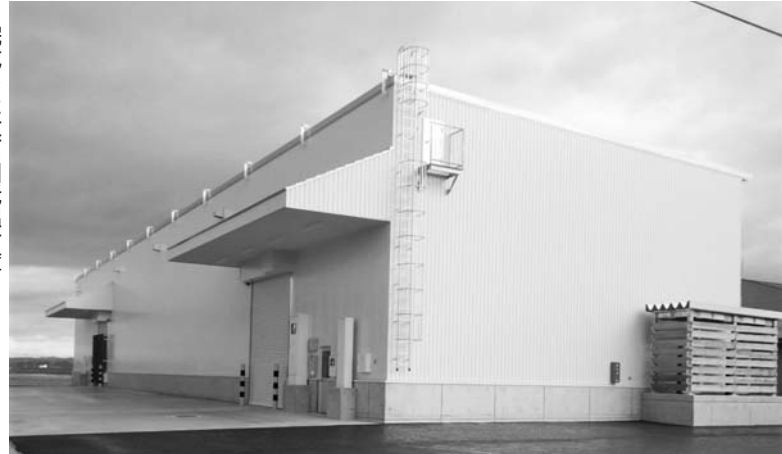
完成した大石田低温倉庫
