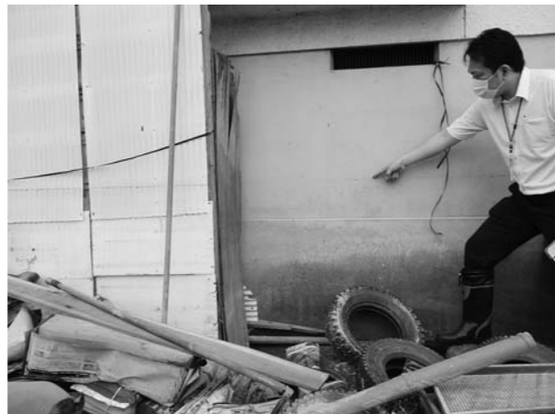
▲胸の高さまで浸水した現場(大石田町)
